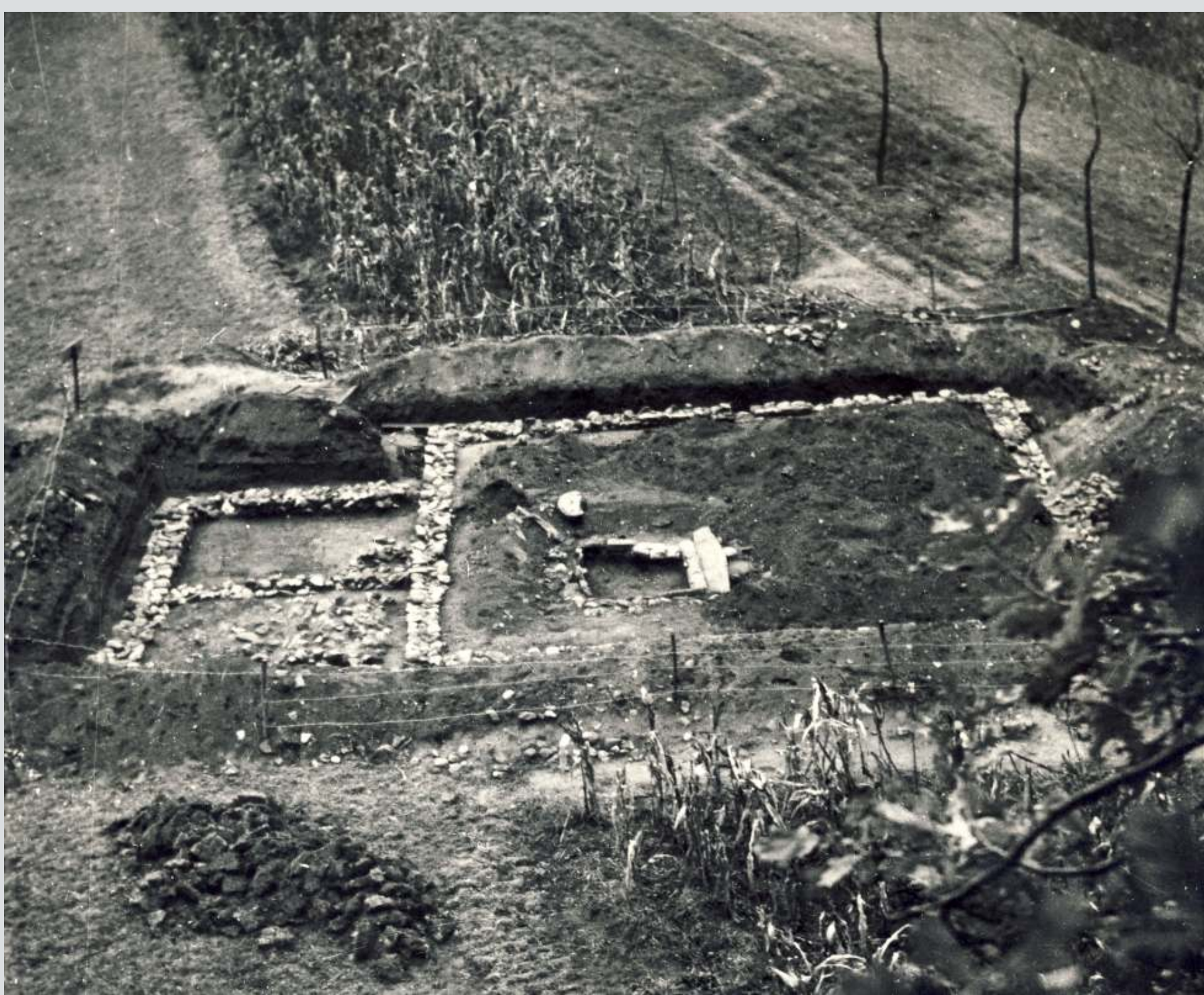
La Casa del Pescatore in corso di scavo The excavation of the House of the Fisherman
