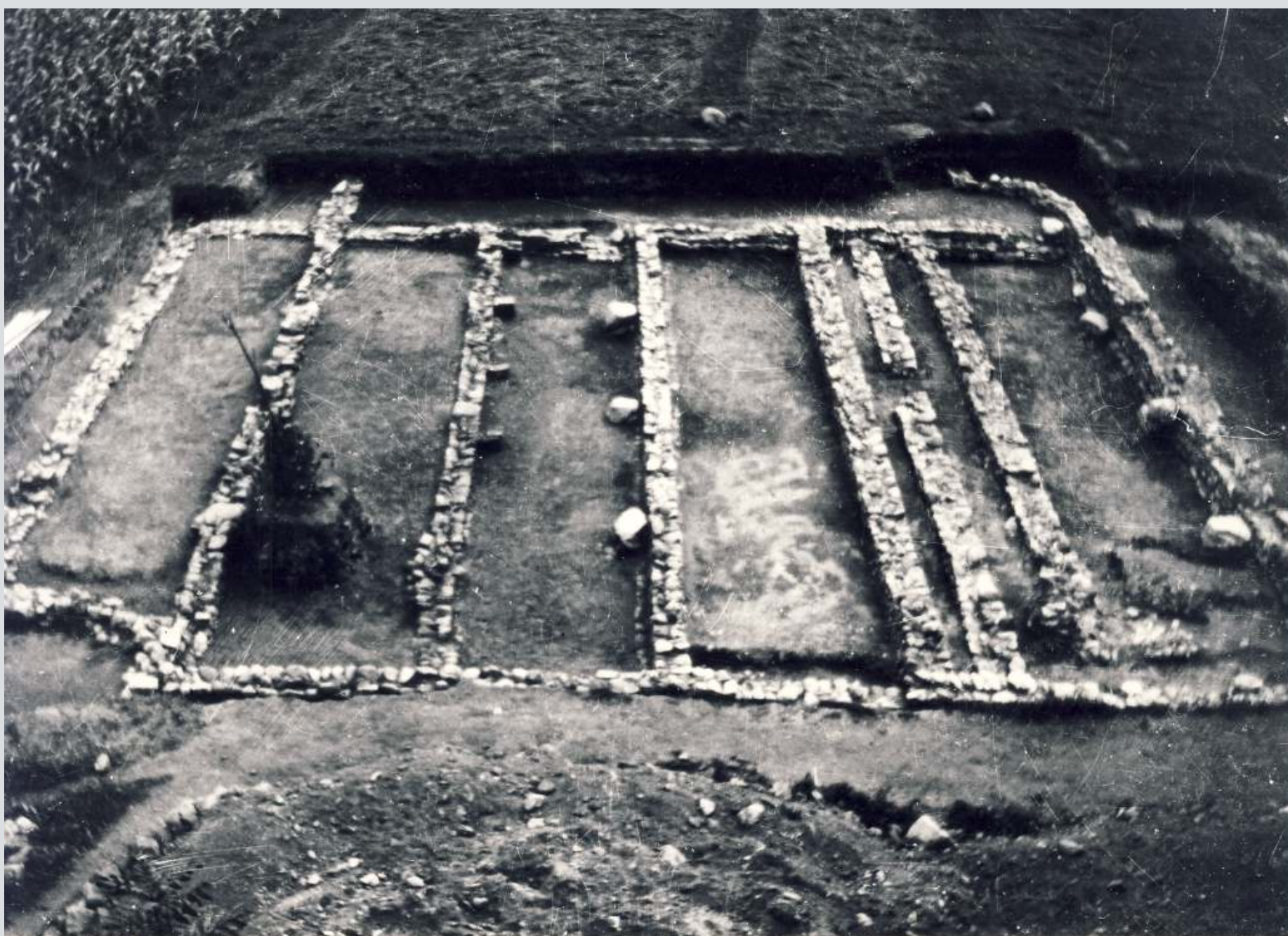
Le Stalle in corso di scavo The excavation of the Stables
